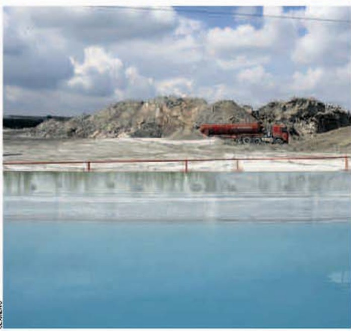
La centrale de Clamens à Villeparisis (Seine-et-Marne) traite 200 000 tonnes de boues de béton par an par lavage et récupère les sables et les gravillons.
