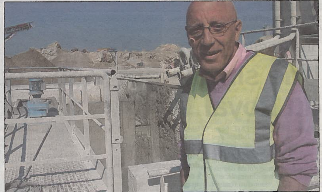
Philippe Clamens a investi 3 millions d'euros dans sa machine qui transforme en sable et gravier les surplus qui encombrant le fond des bétonnières. (LP/C.B.)
